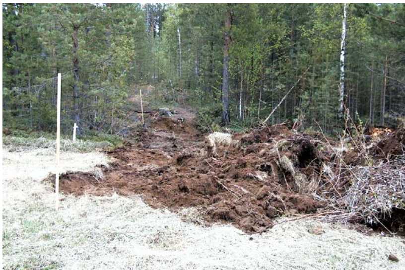
Fig. 2. Området efter avtorvning med maskin. Stakkäppen till vänster i bild utgör koordinat X 7295028 Y 1739747.
