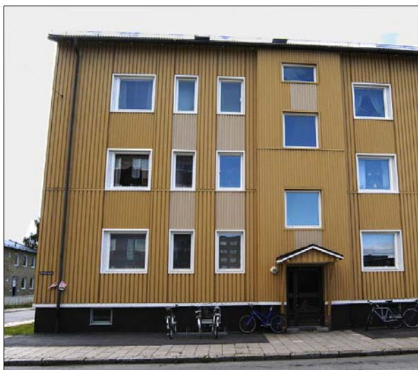
Flerbostadshus på Residensgatan. På två fönsteraxlar och i trapphusets fasad är plåtpartier utbytta. Nyansen på dessa skiljer sig kraftigt från övrig fasad. Nbm acc.nr 2004:120:07
