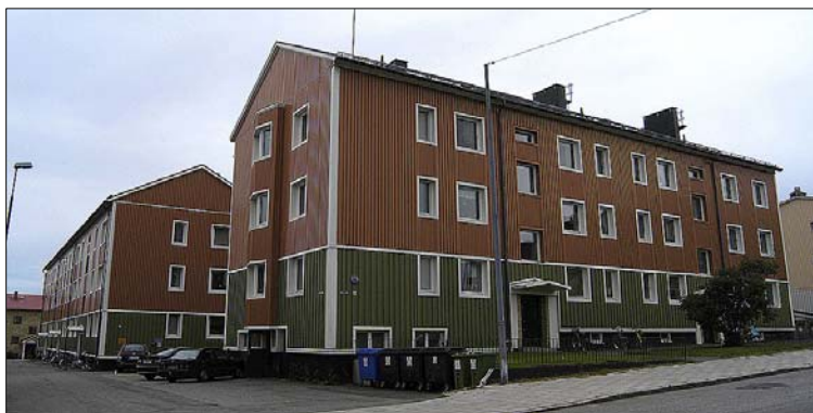
Byggnaderna i orange plåt och grön träpanel. Vid en första anblick syns knappt skillnad på materialen; plåten och träpanelen ger liknande intryck.
