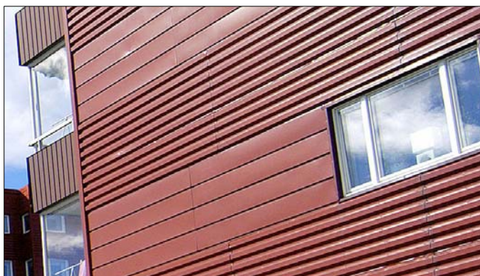
Närbild på ett av husens fasadplåt. Den är i relativt gott skick men på vissa ställen finns tecken på behov av ommålning. Från sydost. Nbm acc.nr 2004:120:01
