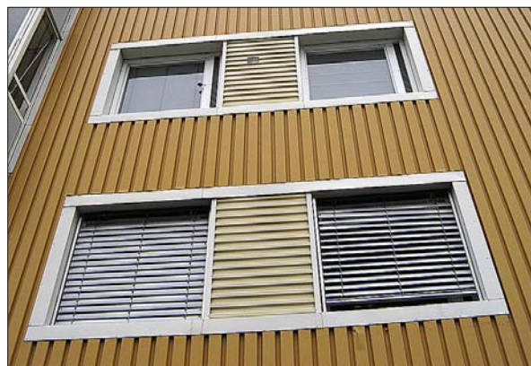
Fönster på ett flerbostadshus vid Sandviksgatan. Smygarna är inte så djupa, troligtvis genom tunnare isolering. Nbm acc.nr 2004:119:15
