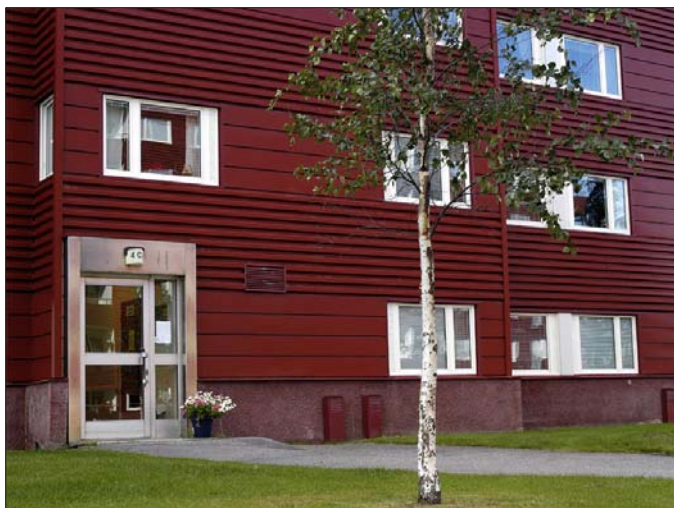
Här syns randningen i fasaden skapad av de smala och bredare profilerna. Plåten börjar en bit upp på väggen och sockeln täcks av ett stöttåligare material. Foto från sydost. Nbm acc.nr 2004:120:06
