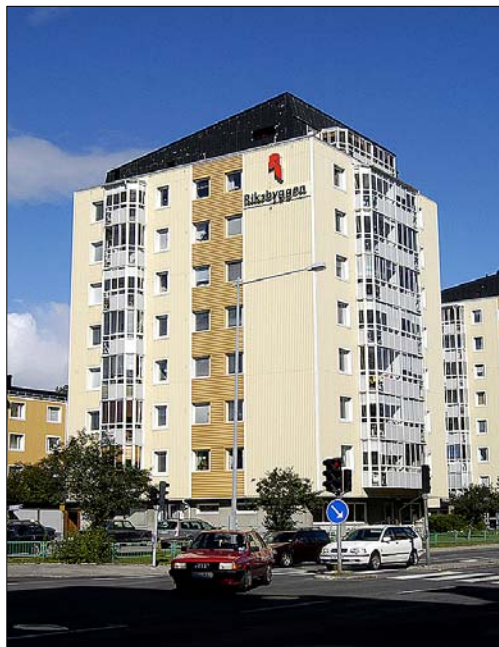
Ett av punkthusen längs Sandviksgatan. Panelens kulör och dimensioner passar bra till byggnadens form. Den grå betongsockeln är inte isolerad. Nbm acc.nr 2004:120:14
