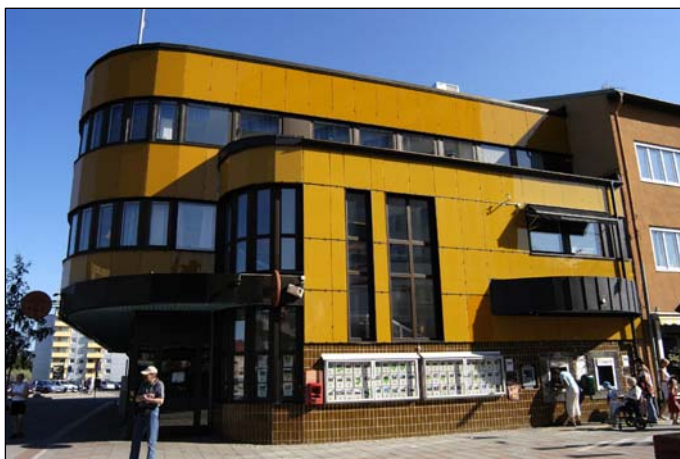
Tillbyggnaden för trapphus och automater på nordvästfasaden. Nbm acc.nr 2004-103-24
