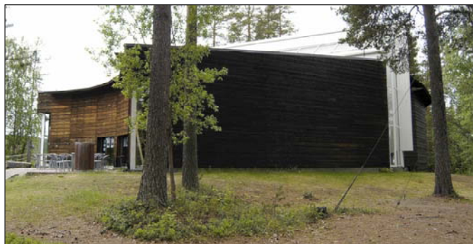
Kontrasterna mellan den mörka nordöstfasaden och den ljusa sydostfasaden. Längst till höger filmsalen. Nbm acc.nr 2004:84:04
