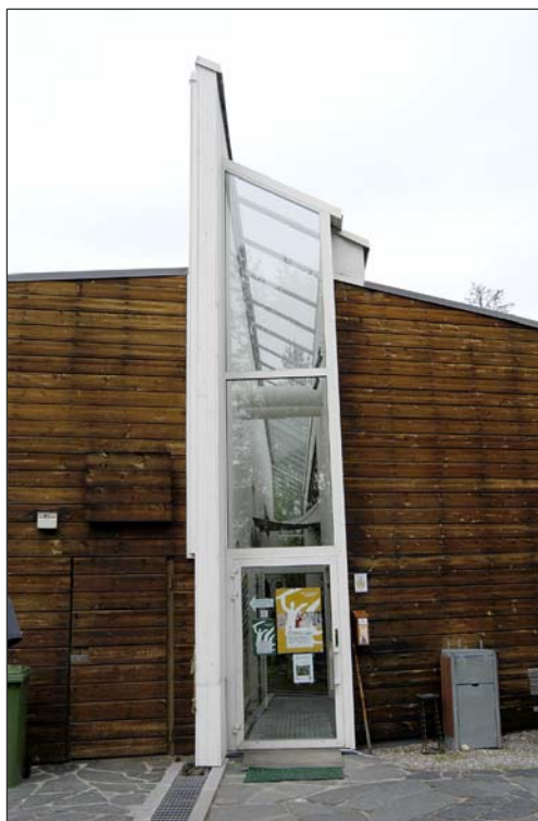
Glaspartiet och entrépartiet. Här syns också en av de panelklädda dörrarna. Foto från sydväst. Nbm acc.nr 2004:84:07
