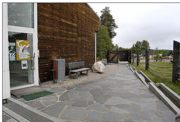
Skiffergången, vattenrännorna och entrén. Från söder. Nbm acc.nr 2004:84:09
