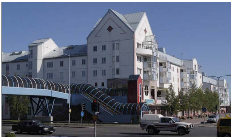
Utsikt över det tornliknande hörnpartiet i nordväst. Nbm acc.nr 2003-95-29
