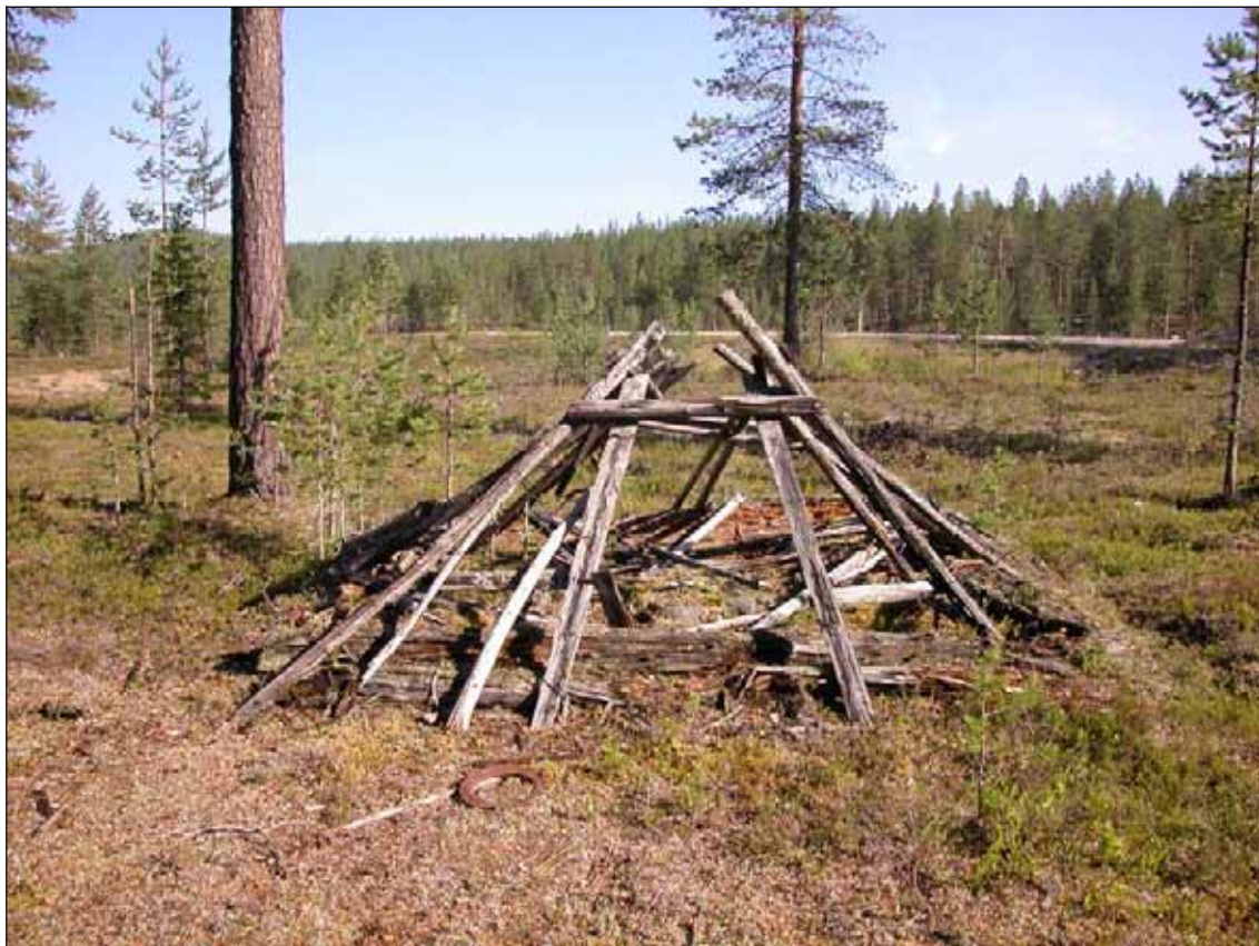
Fig. 6. En kvarvarande stommen av en kolarkåta från Rivedsjaurns kommun. Till skillnad från en skogssamisk träkåta har en mullbänk uppskottats på utsidan av de timrade stockvarven. I centrum är en nästan helt övermossad härd. Kolarkåtan ska ha uppförts någon gång under 1940-talet och intill kåtan är två kolbottnar.
