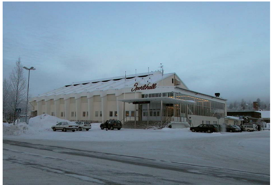
Idrottshallens exteriör och entré. Nbm acc.nr 2002-30-06.
