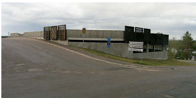
Parkeringsdäcket från söder. I förgrunden Sjukstugegatan, till vänster i bild rampen till det övre däckets. I bakgrunden sjön Västra Ringlet. Nbm acc.nr 2006:31:22
