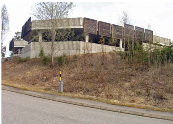
Från nordväst. I förgrunden Ringelvägen och sluttningen som ger parkeringsdäcket en upphöjd position i landskapet. Nbm acc.nr 2006:31:03
